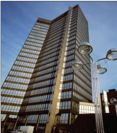
Leistungsfähige Backbone-Infrastruktur: Die Rechenzentren der Stadt Essen sowie das Rathaus sind über 10-Gigabit-Ethernet-Komponenten von Extreme Networks miteinander gekoppelt.
